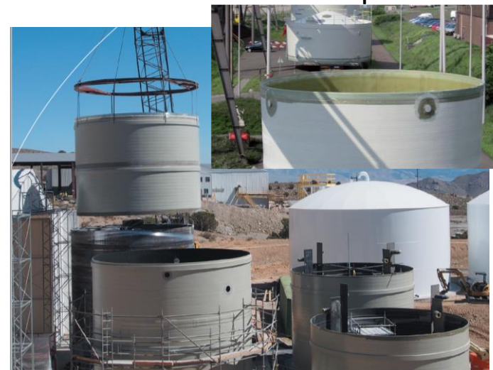
Primer izgradnje na lokaciji
