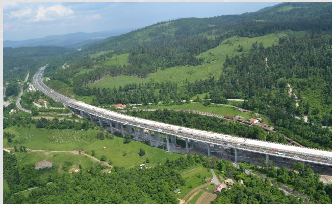
Sanacija viadukta Ravbarkomanda
