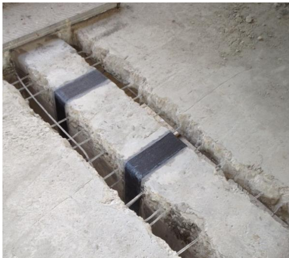
Polno objetje prereza nosilca s SikaWrap® pasovi
