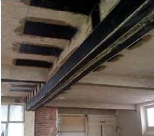
CRP trakovi za sanacijo betonskih preklad in plošč
