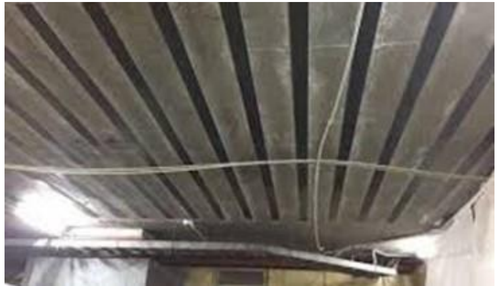
CRP trakovi za sanacijo betonskih preklad in plošč
