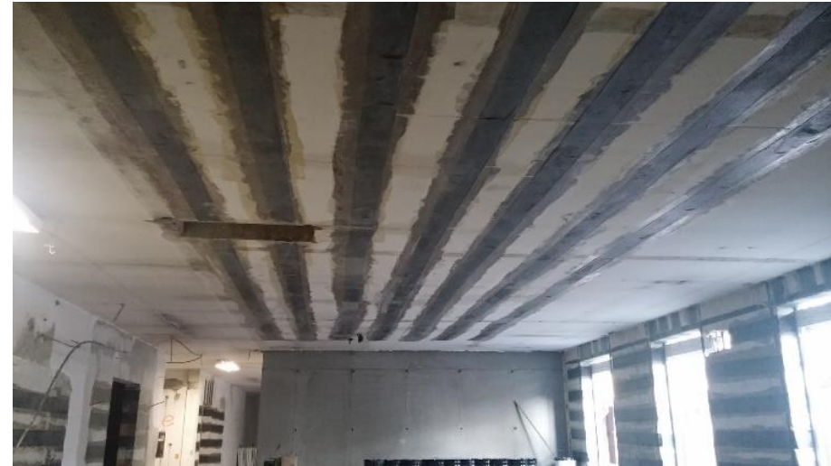
Ojačitve upogibno obremenjenih elementov
